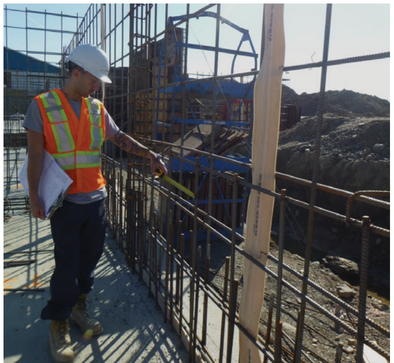
Mesure de l'espacement de l'armature. © Consultants Lemay & Choinière inc.
