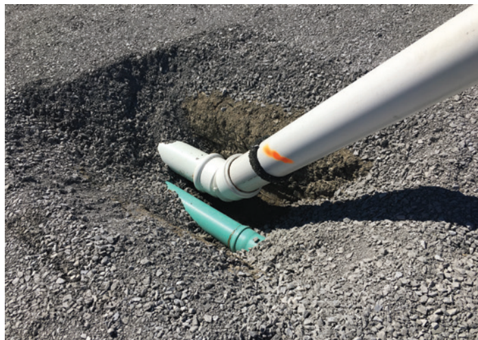
Bande BFL-Mastix autour du tuyau d'aménagé et sol préparé pour recevoir une masse de béton autour du coude.
