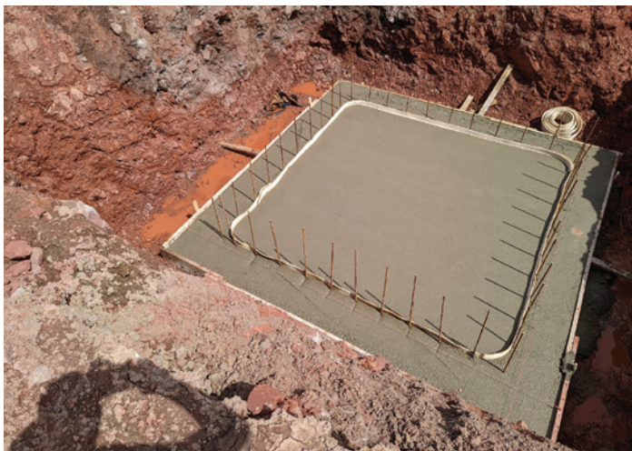
Dalle de béton d'une préfosse, bande d'étanchéité et acier d'armature.
