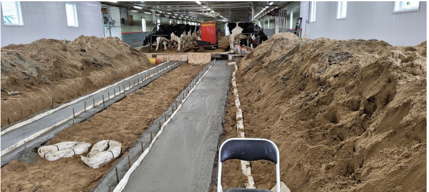
Dalle et semelle de dalot pour les déjections animales, bande d'étanchéité et acier d'armature. © Consultants Lemay & Choinière inc.
